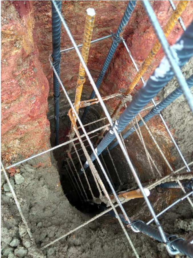
12 - Fundação muro de arrimo
