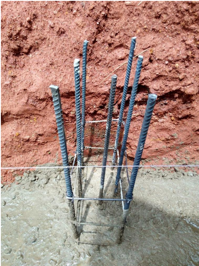
14 - Estrutura muro de arrimo
