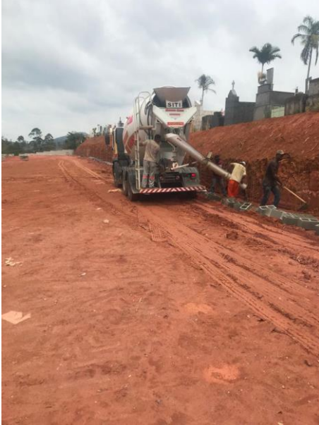
7 - Concretagem de baldrame muro de arrimo
