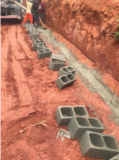
5 - Execução no baldrames
