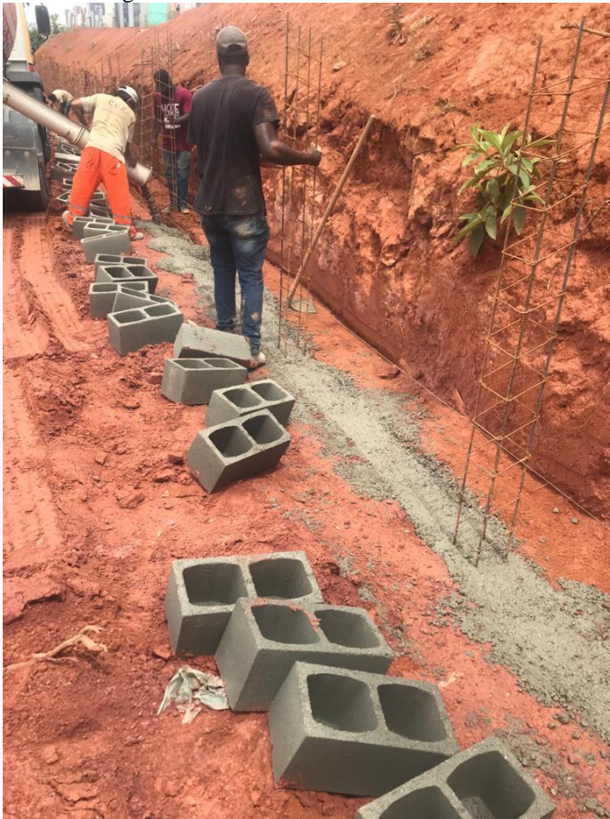
4 - Concretagem de baldrame
