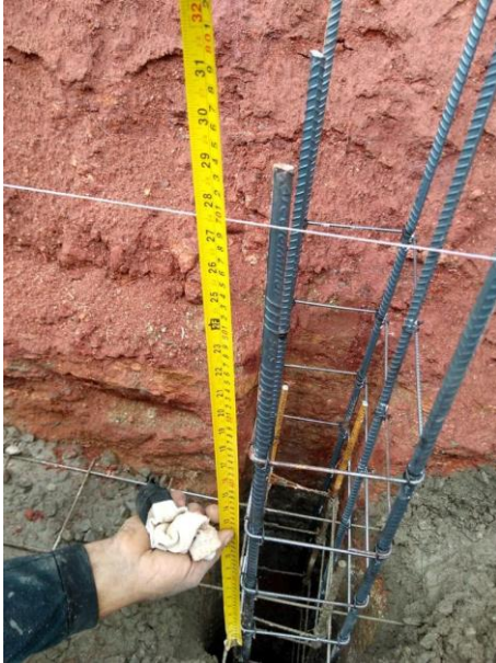
13 - Estrutura muro de arrimo
