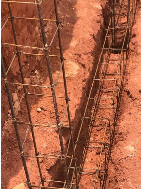
15 - Fundação do Muro de arrimo
