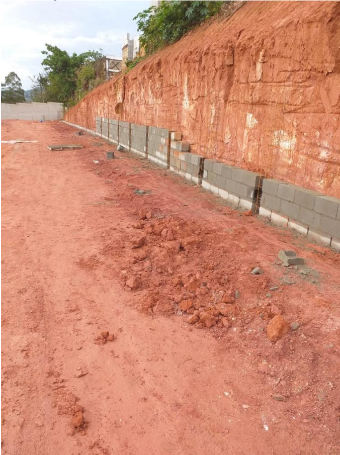
6 - Execução de alvenaria
