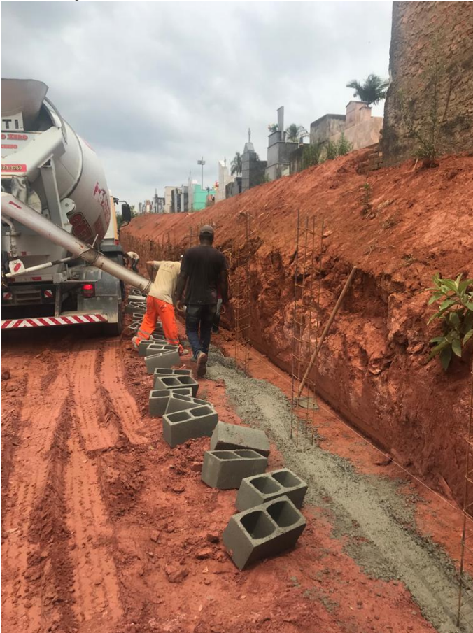
8 - Execução de concreto no baldrame no muro de arrimo
