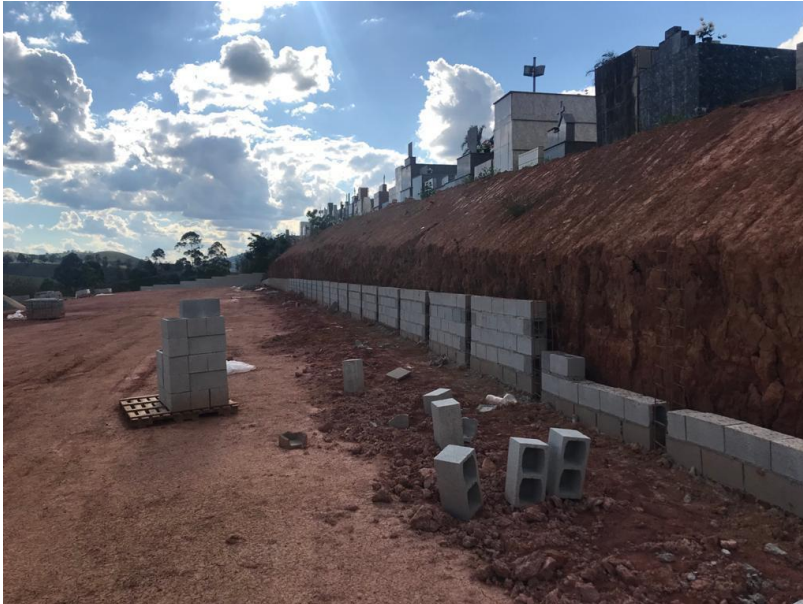
2 - Alvenaria do muro de arrimo
