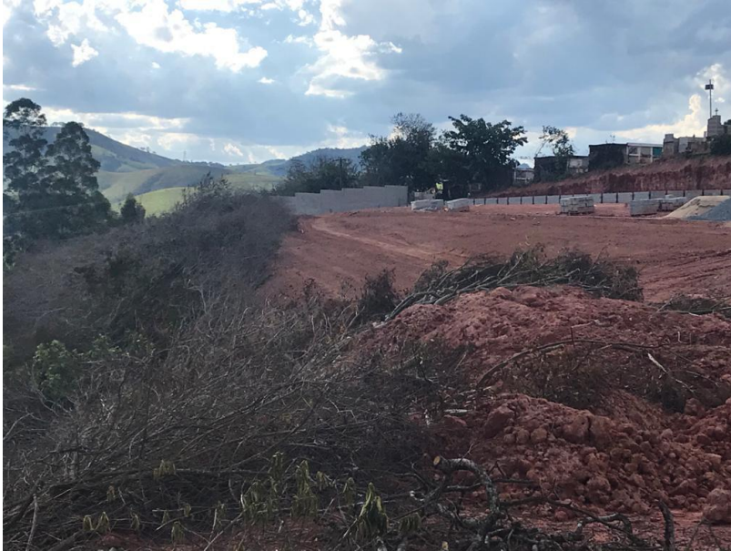
3 - Podas de árvores para execução de muro
