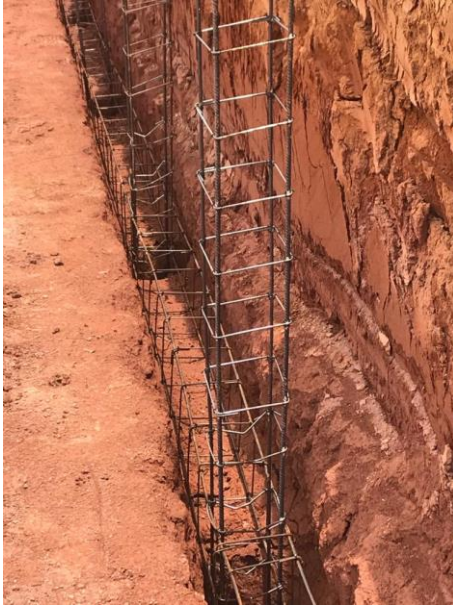
11 - Pilares e baldrames muro de arrimo
