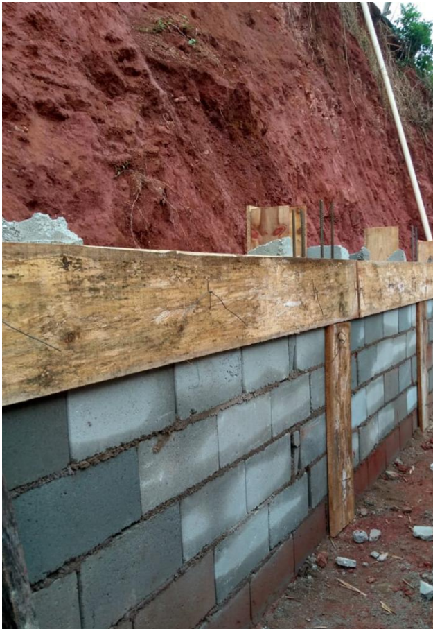
10 - Alvenaria muro de arrimo
