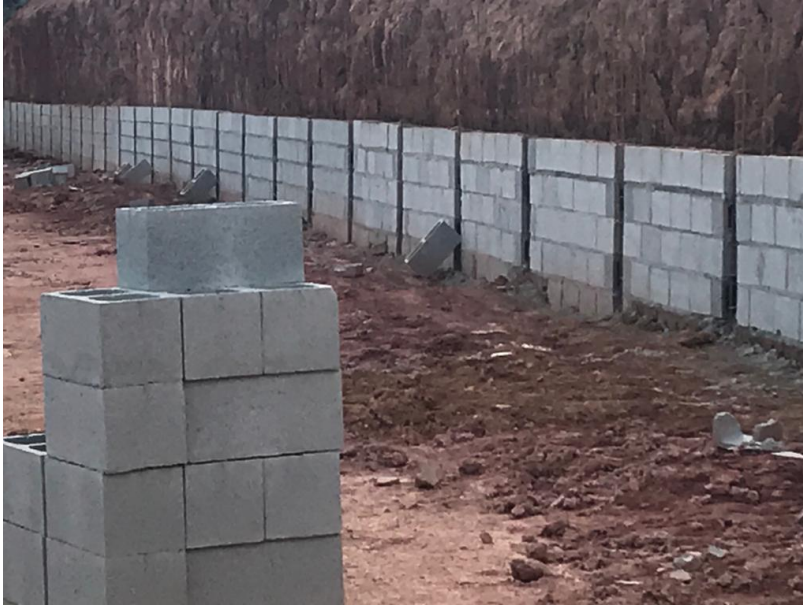
1 - Alvenaria de muro de arrimo
