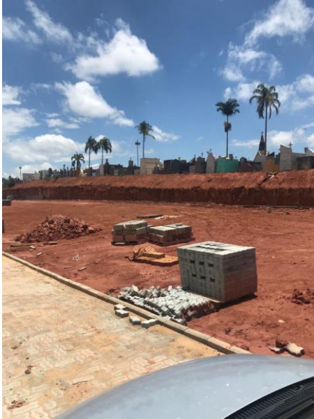
9 - Vista frontal muro de arrimo
